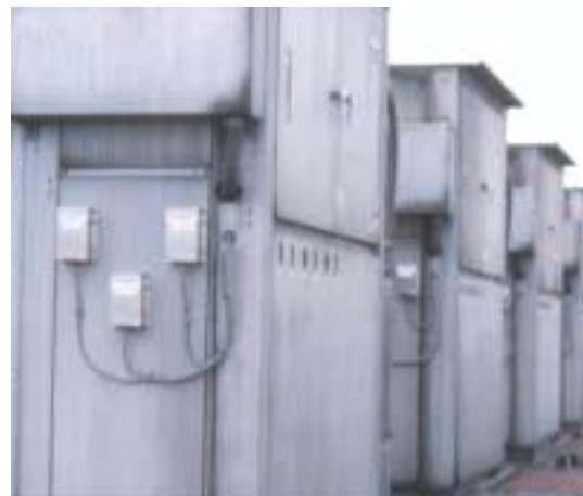
新制御システムを付加したカシオ電子工業(株)のクーリングタワー
