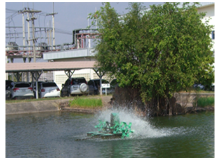
貯水池の空気取込用攪拌機
