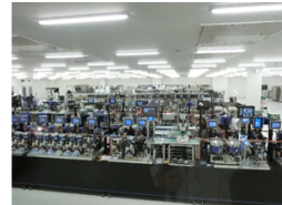
最新式空調設備のクリーンルーム
